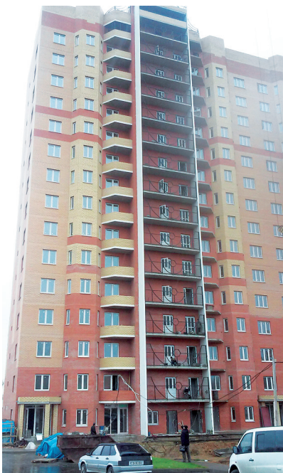
Многokвартирный дом в Можайске, который возводит ООО «НИСА» (март 2017 г.)
